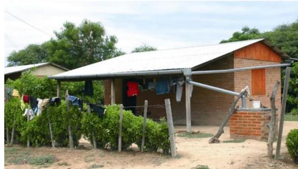
Vivienda diseñados con techos y canaletas para colecta de aguas de lluvia y aljibes (pozos) de captación
